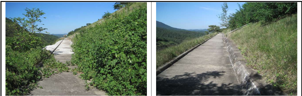
【그림 2.3.3】 배수시설 전경
